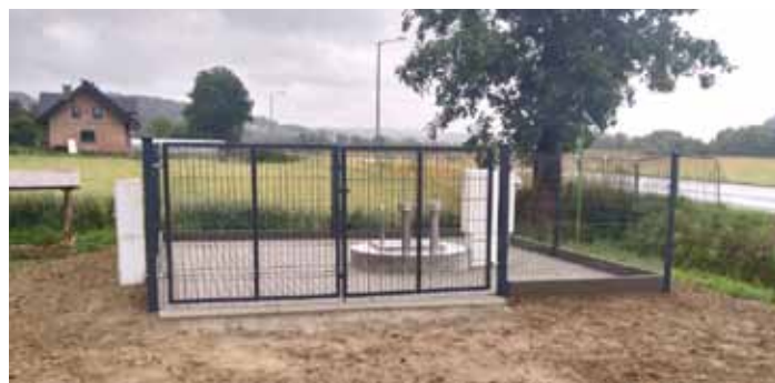
Wybudowana przepompownia ścieków – fot. ze zbiorów Urzędu Miejskiego w Dynowie
