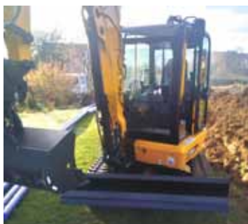
Budowa sieci wodociągowej w Dynowie – fot. ze zbiorów Urzędu Miejskiego w Dynowie
